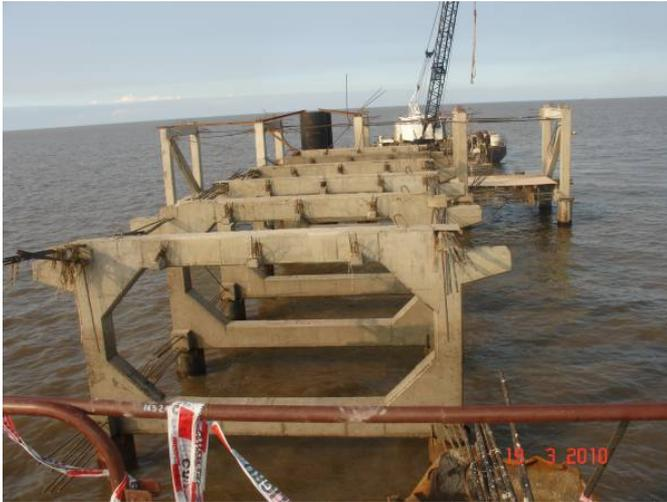
**LA PROLONGACION DEL MUELLE SIGUE AVANZANDO.** Tan solo falta la colocación de un pórtico para completar la totalidad de los correspondientes a la prolongación del muelle. Luego comenzarán a construir las vigas de vinculación entre cada uno de ellos que conformarán la estructura. Simultáneamente sobre la última parte del muelle están armando las lozas que en un total de 12 conformarán el piso del nuevo morro, sobre el cual luego se construirá el nuevo refugio y mareógrafo.
